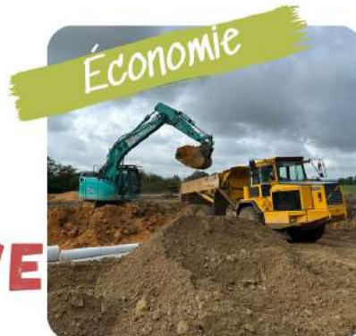
Début des travaux de la deuxième ZA du Poteau - octobre 2024
