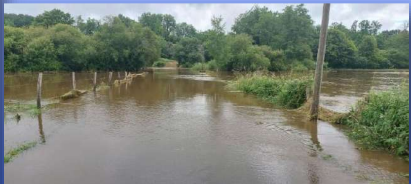
Le pont du radier
